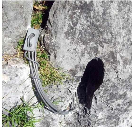
**Abb. 9 Drahtschlinge in einer Sanduhr**
