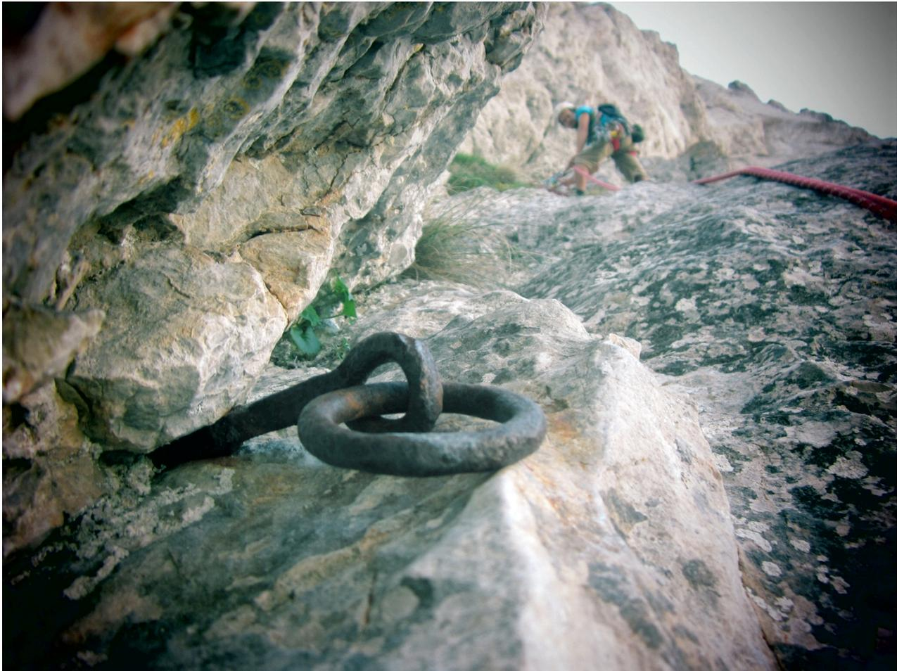
**Abb. 10 Vermutlich 1932 von Raimund Schinko gesetzter Haken am kleinen Winkelkogel<sup>13</sup>**
