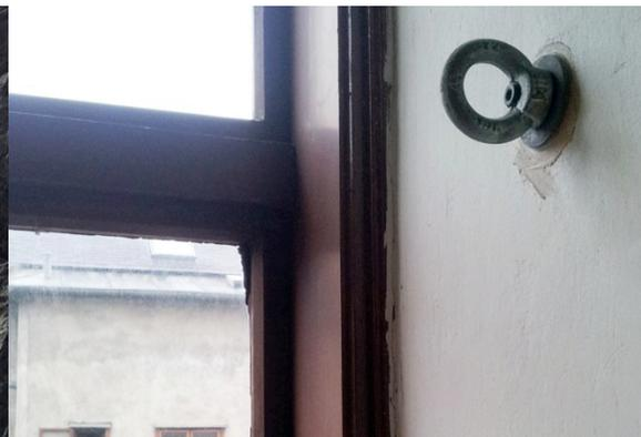
**Abb. 61 Ringmutter in einem Stiegenhaus**
