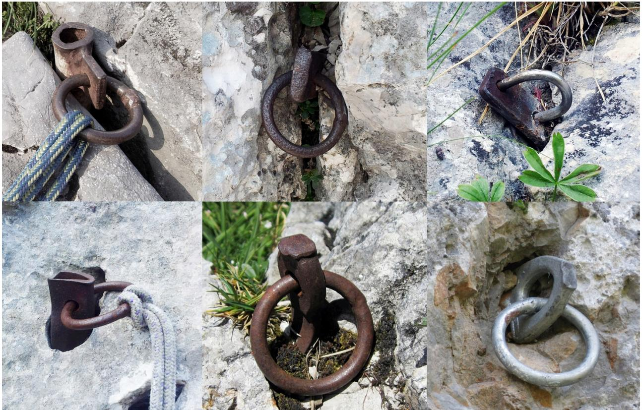
**Abb. 25 Verschiedene im Hochschwab gesetzte Mauerhaken**
